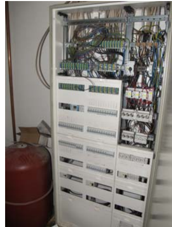
10 Heizungsraum ELT-Hauptverteilung
