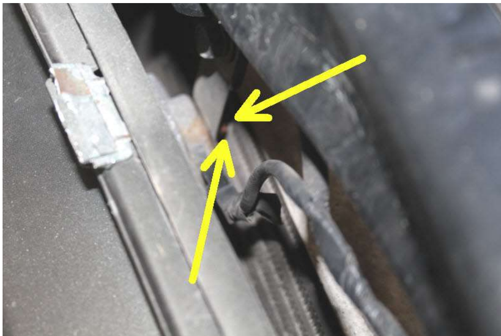
Bild 25 Beschädigung Ladeluftkühler ( Verschraubung der Hupe eingedrückt )
